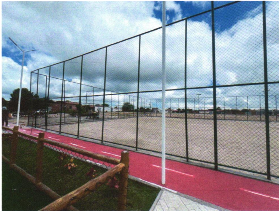
Foto 15 - Poste decorativo 2 pétalas, em aço galvanizado com difusor em vidro transparente temperado, com 3m/4m, inclusive lâmpada de led 50w
