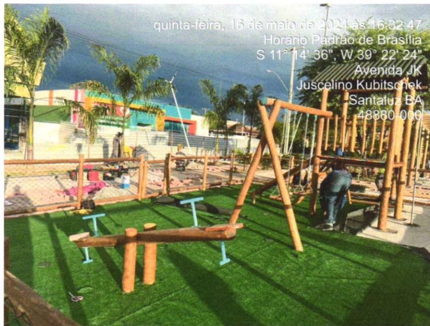
Foto 05 - Fornecimento e assentamento de Casinha do Tarzan em eucalipto tratado, com pórtico de um balanço
