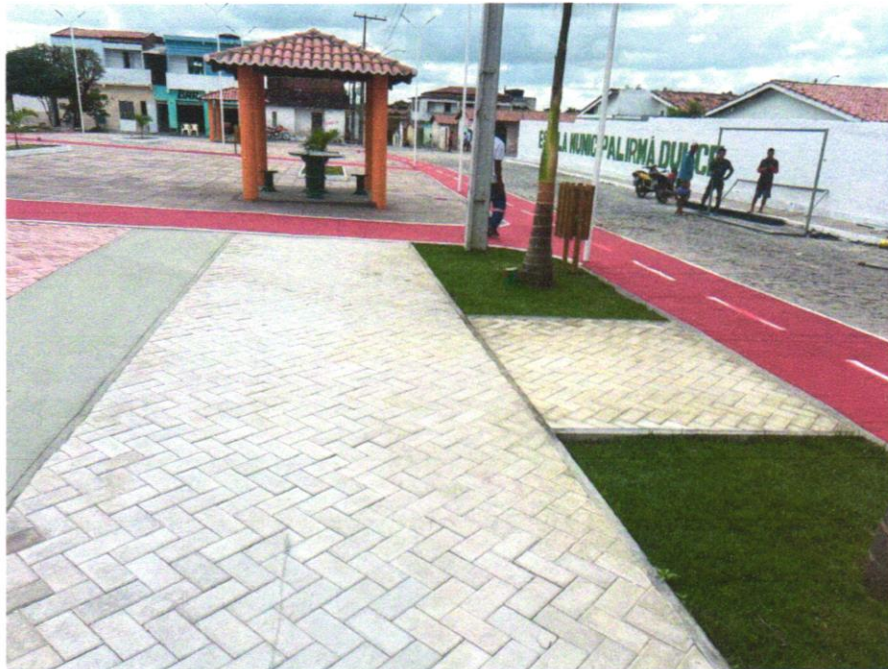
Foto 03 - Pavimentação em bloco de concreto vibroprensado, intertravado, cor natural, 10x20cm, e=6cm, 46un/m 2 , NBR9781, Fck(min)=35MPa, sob coxim areia grossa compactada c/ placa vibratória, e(comp.)=6cm, rejuntado c/ areia fina.
